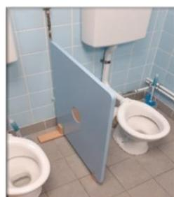
Installation d'une cloison dans les WC du RPE
