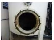
d'être rénovés. Le revêtement intérieur a été recouvert d'une résine armée fibre de verre filtre. La société TECNOFIL s'est occupée de la rénovation des filtres à diatomée du bassin sportif et du bassin ludique.
